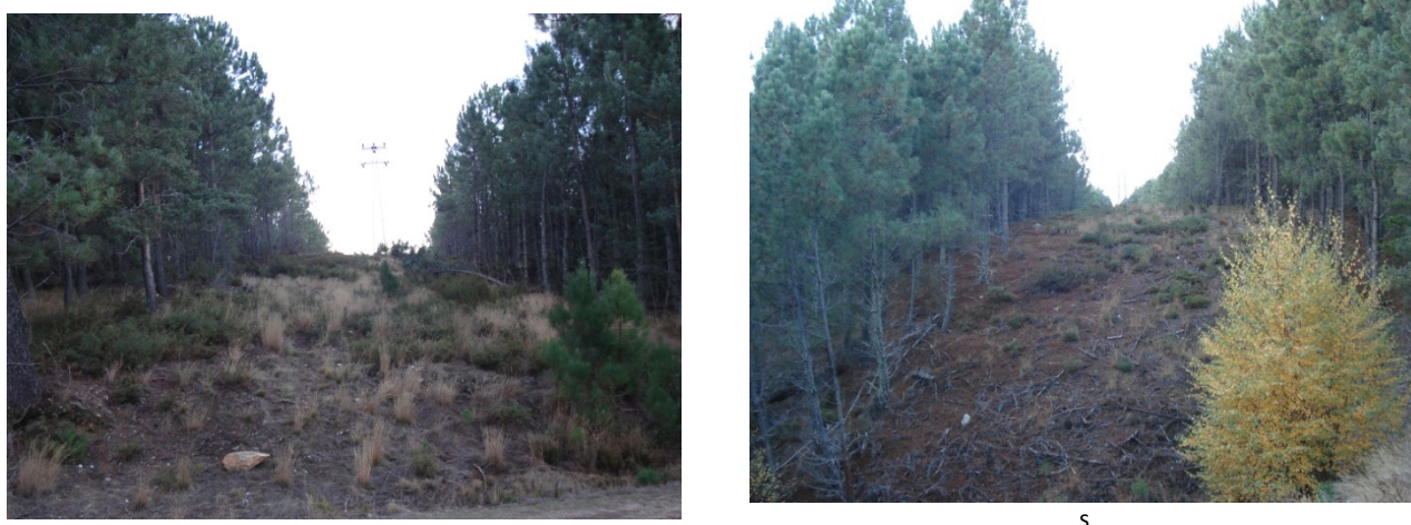
Figura 3. Exemplo da FGC da rede elétrica, entre Portelo e Montesinho (freguesia de França), intervencionada em 2008
