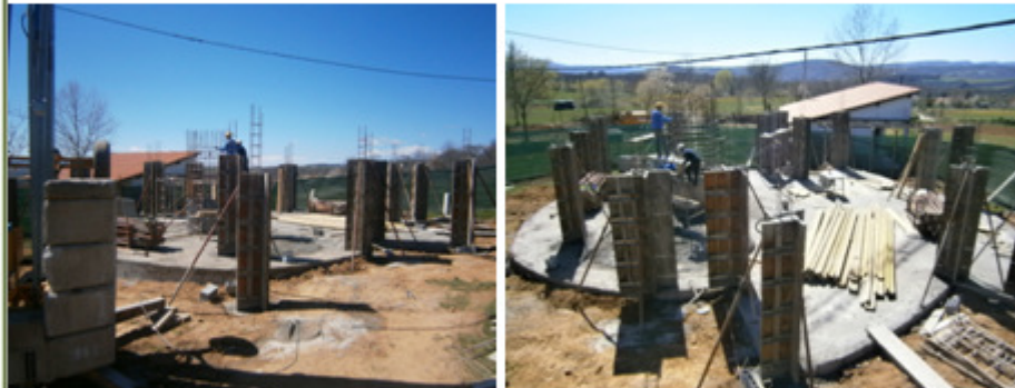
Construção bar/salão de apoio em Santa Rita - Terroso
