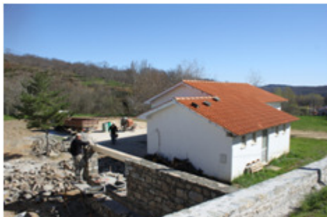
Requalificação da zona envolvente ao Centro de Convívio do Zeive
