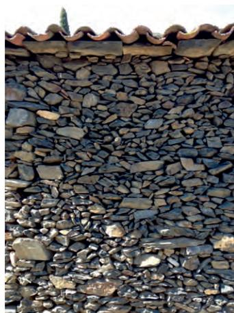
Alvenaria de pedra de junta seca
