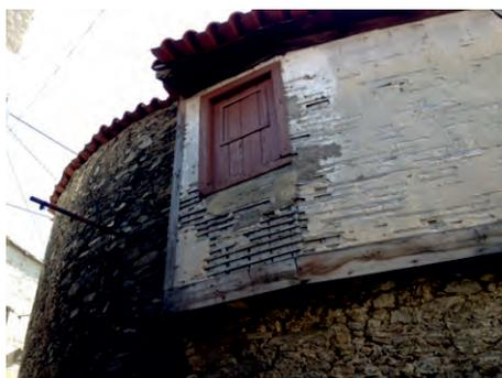
Destacamento do revestimento do tabique
