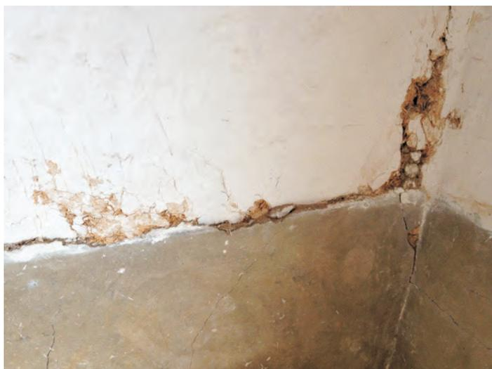
Fendilhação e desagregação dos revestimentos
