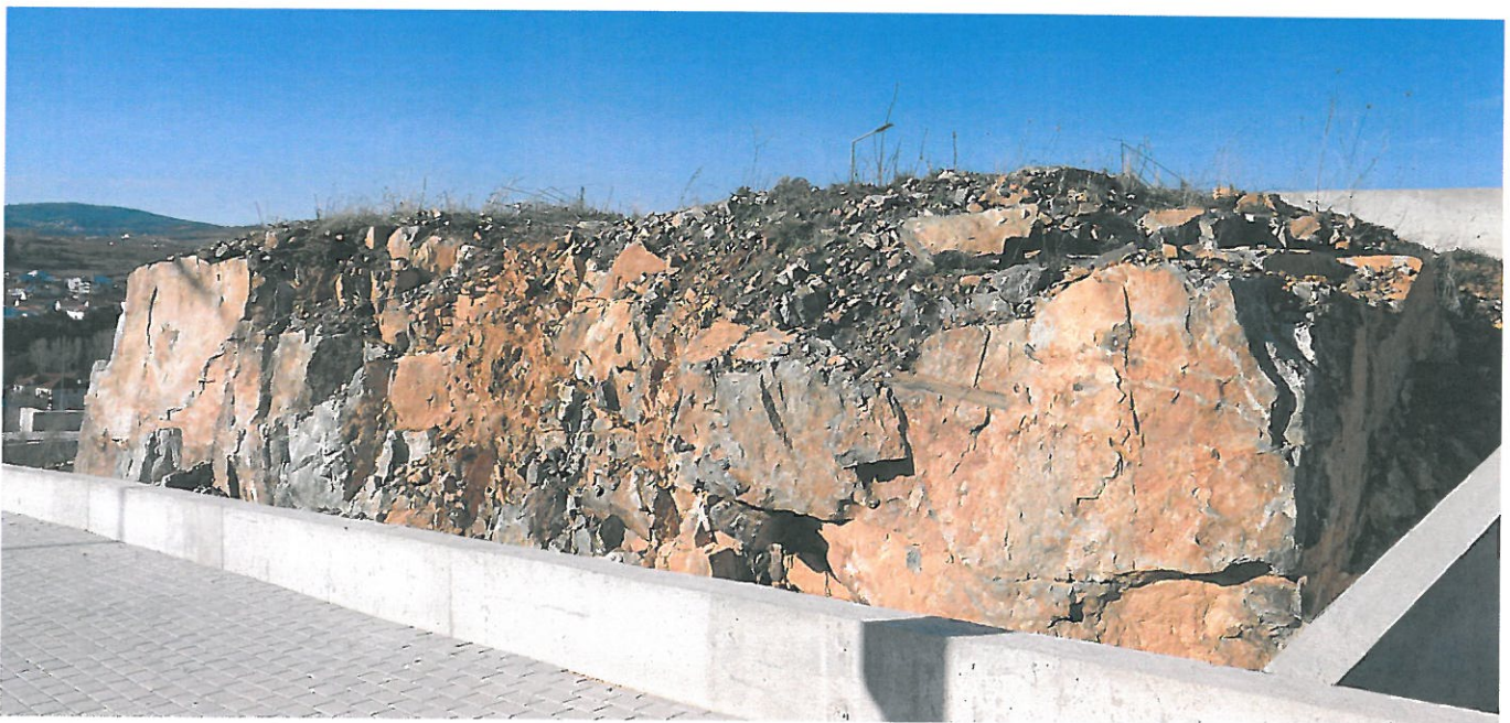
Fotos 13, 14 e 15: Perspectivas gerais sobre a 2. a zona onde afloram granulitos máficos, localizada, grosso modo, a sul do lote 33 do projecto de loteamento
