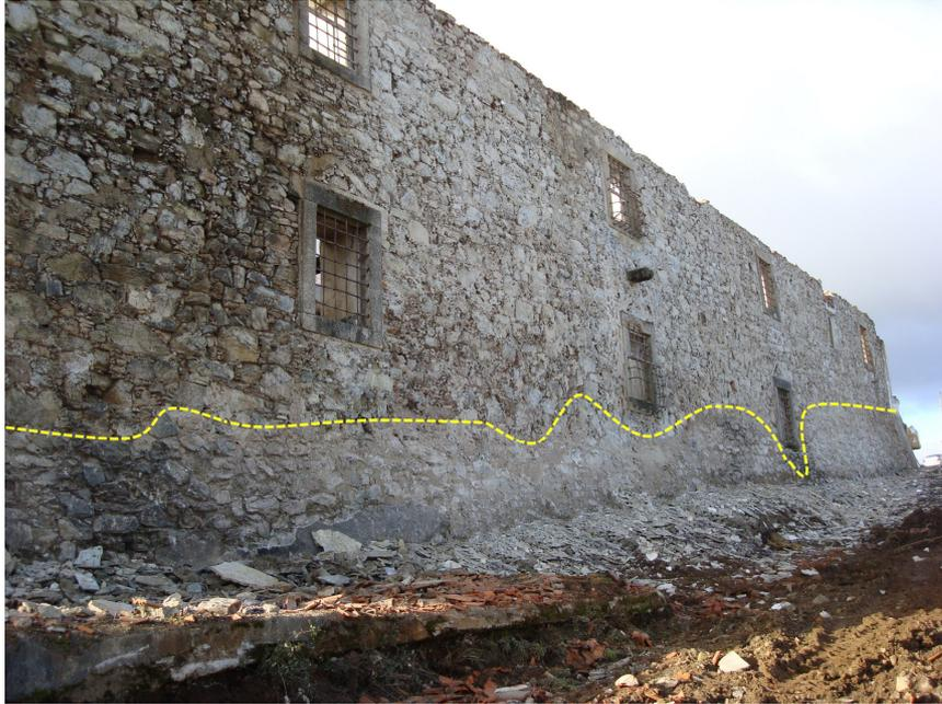
19. Perspectiva parcial da parede da caserna construída, no séc. XIX, sobre a cortina do séc. XVII (o tracejado separa os dois momentos construídos)
